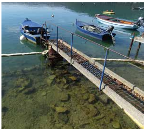
Slika 15: Obalna linija sa mnoštvom dotrajalih pontona
