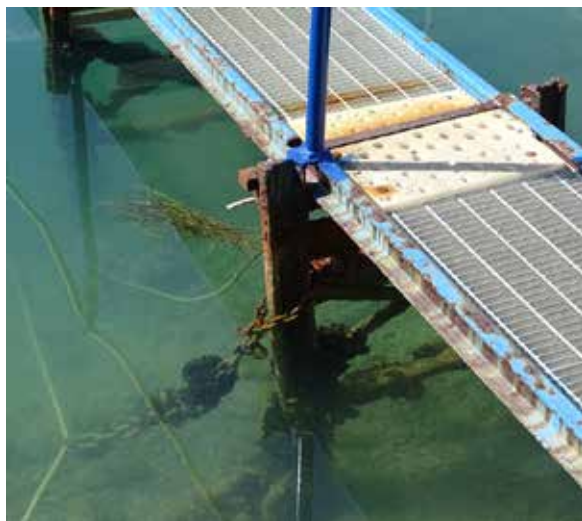
Slika 21: dagnje nataložene na metalne elemente
