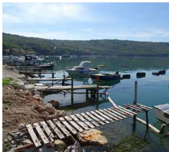
Slika 14: Obalna linija sa mnoštvom dotrajalih pontona
