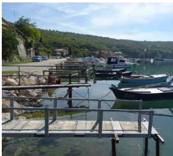
Slika 11: Obalna linija sa mnoštvom dotrajalih pontona
